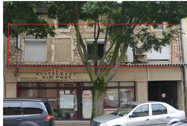
Bouchage des baies et équipement en volets roulants
