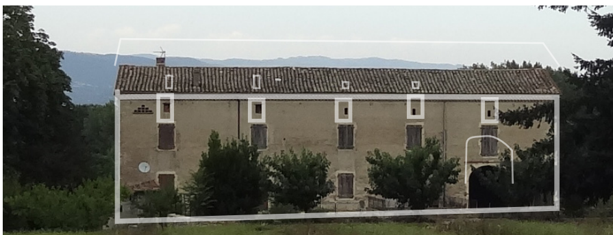
Les constructions sont organisées sur une volumétrie simple. Les percements prennent place régulièrement sur la façade. Les linteaux des accès charretiers sont cintrés : selon l'importance de l'ouverture, soit en plein cintre, soit en anse de panier.
