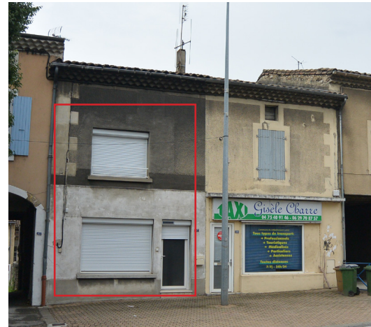
Perçements horizontaux inappropriés
