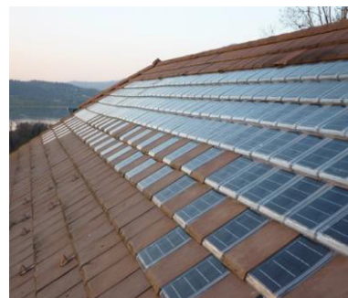
Exemples d'intégration de panneaux solaires thermiques
