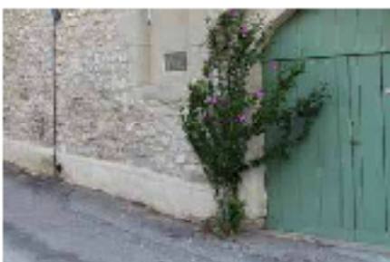
Hibiscus se développant le long d'une façade
