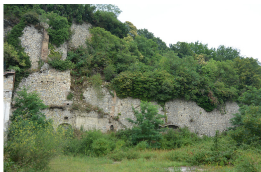
Vue depuis les jardins arrières sur les remparts du Haut Livron
