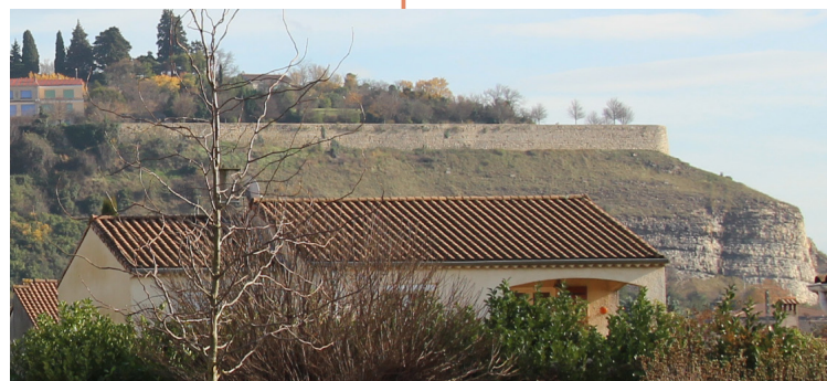
Portion des remparts du Haut Livron dégagée et restaurée
