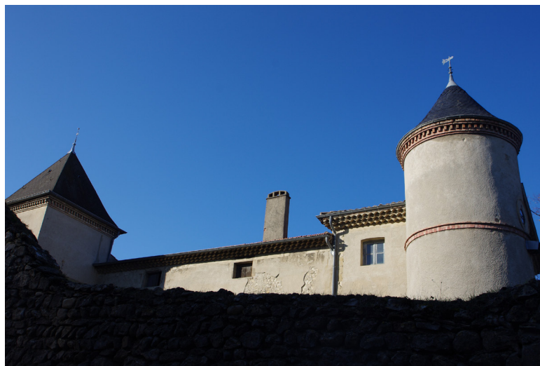
Vue depuis la rue par dessus les murs d'enceinte sur les deux tours
