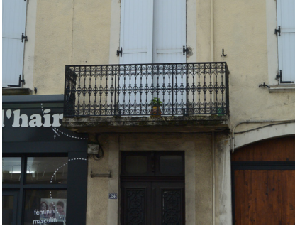
Balcon en serrurerie de fonte sur une maison urbaine
