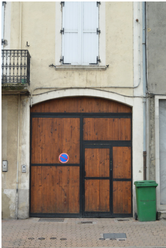
Porte charretière en bois : assemblage de lames verticales
