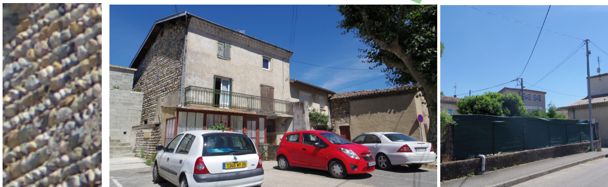
La proximité du Rhône a favorisé l'utilisation de galet dans l'appareil des murs
