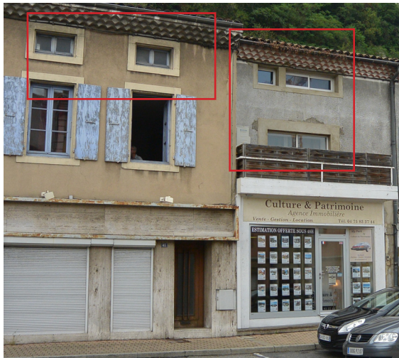
Transformation des fenestrons
