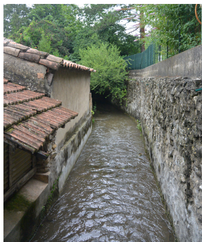
Canal des moulins, entre le coteau et la RN7
