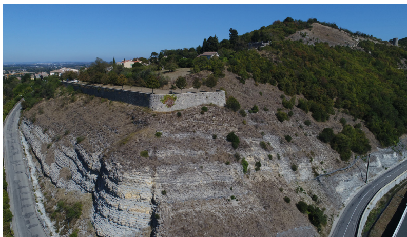
Vue sur la partie restaurée des remparts de la seconde enceinte
