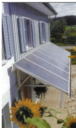
Ex d'intégration sur toitures en tuiles, châssis solaire et auvent solaire
