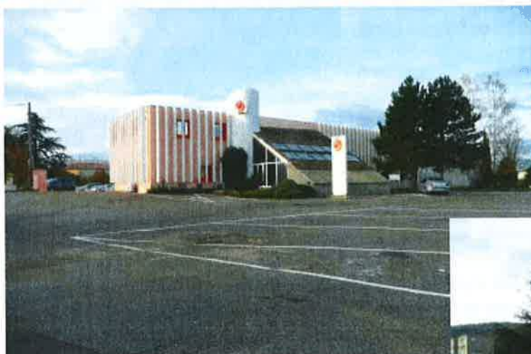
Bâtiments existants sur cette zone.
